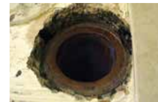
Bündig abgeschnittene Rohre
