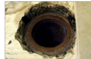
Bündig abgeschnittene Rohre
